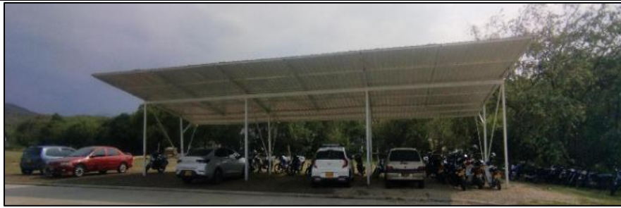
Parqueadero Sede Ciudad Universitaria Navarra Área de estacionamiento 105 m 2
