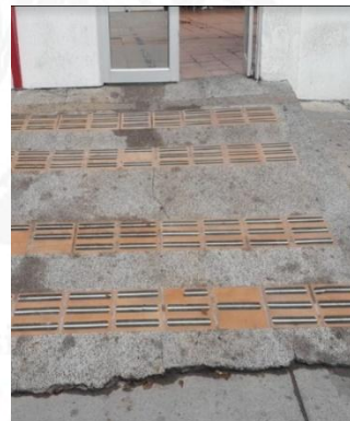
6. Rampa acceso sede parque (superficie antideslizante)
