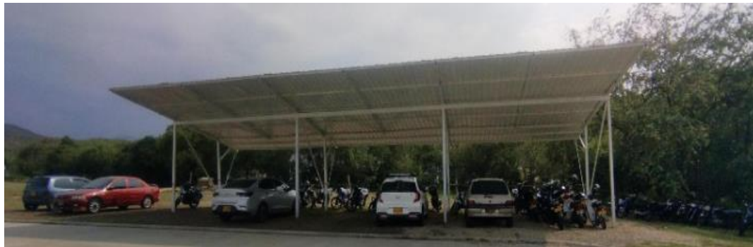
Figura 2. Parqueadero vehículos – Campus Uninavarra – Km 8 vía Neiva – San Antonio
