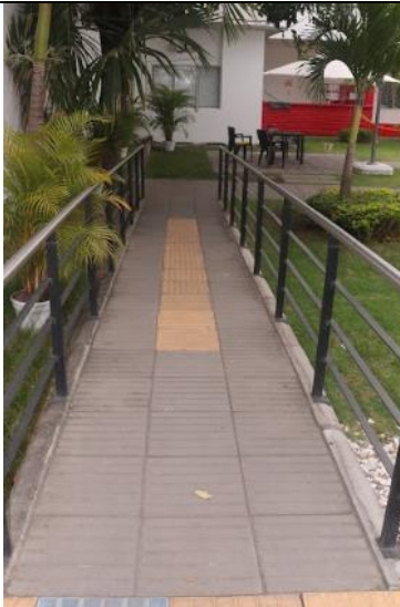
3. Rampa de acceso sede internacional campus
