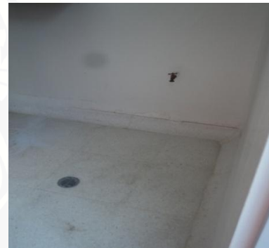
Ilustración 14 Drenaje y acometida de agua
